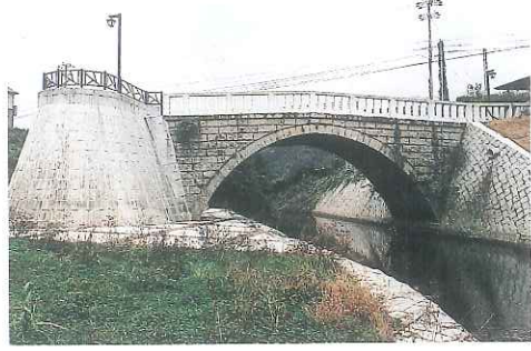
④ 指定 (建) 旧岡田橋 (明治21年 (1888) 舞鶴市)
