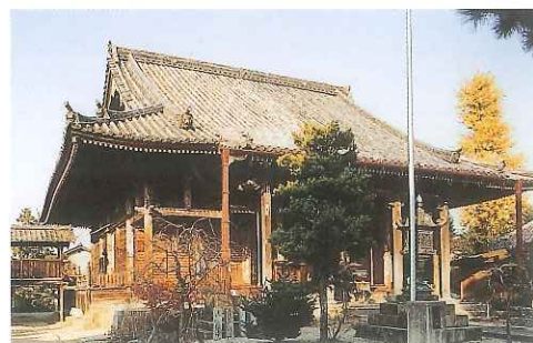
⑮ 指定(建) 穴太寺本堂 (享保20年(1735) 亀岡市)
