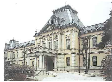
④ 指定 (建) 京都府庁本館 (明治37年 (1904) 上京区)
