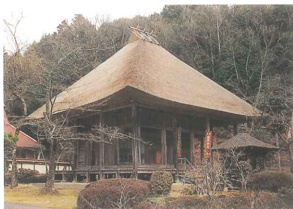
岩王寺建造物保存修理事業
