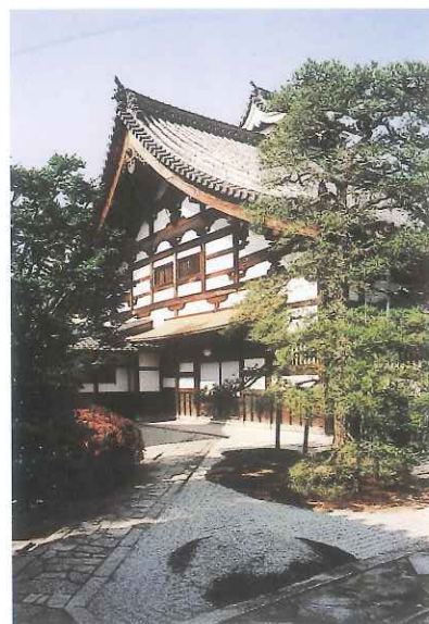
龍泉菴建造物防災施設事業
