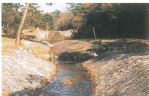
⑯ 指定 (建) 不動川砂防施設 (明治時代・山城町)
