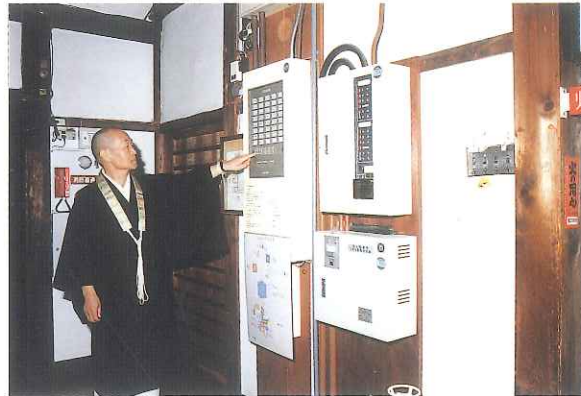
知恩寺建造物防災施設事業
