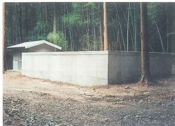
松尾寺耐震貯水槽（舞鶴市）
