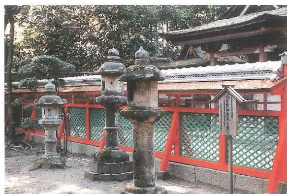
相楽神社文化財環境保全地区(透塀修理)
