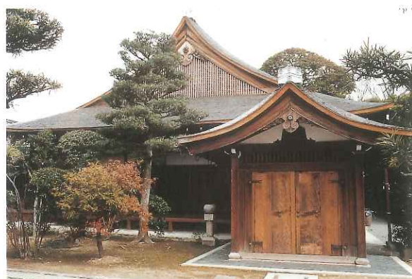
養源院本堂解体復原修理
