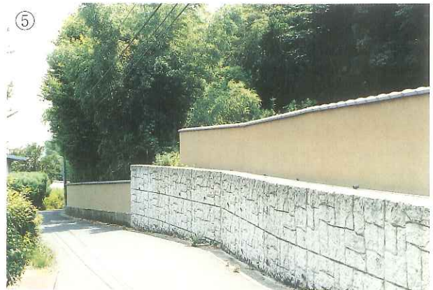
正法寺文化財環境保全地区境界塀
