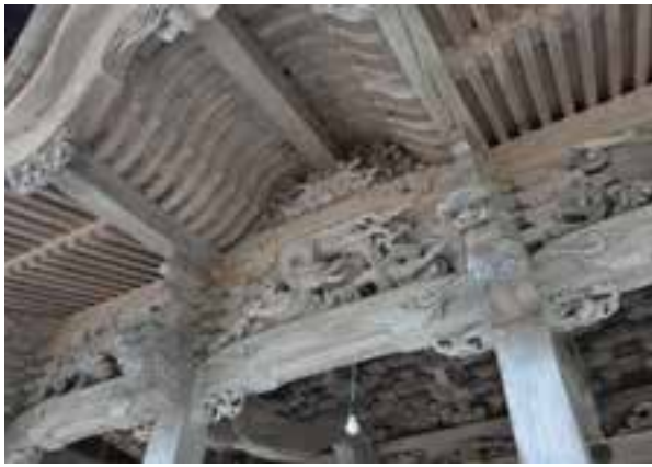
庇軒廻りの彫刻
