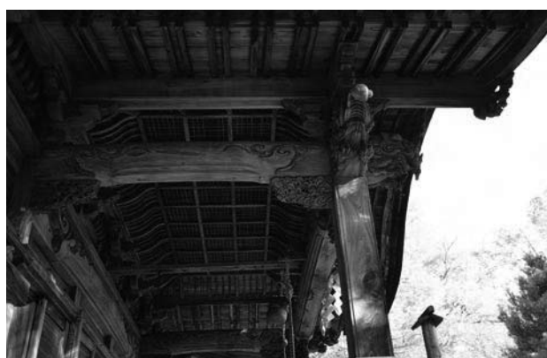
拝殿 向拝繫虹梁
