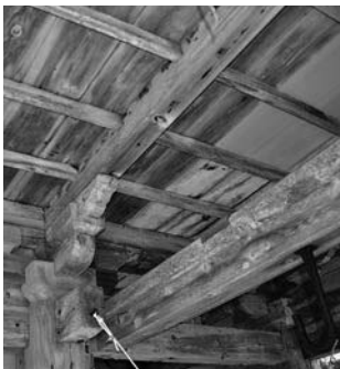
山門転用材（天井桁）
