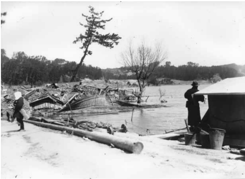
網野町小浜の道路陥没による浸水
