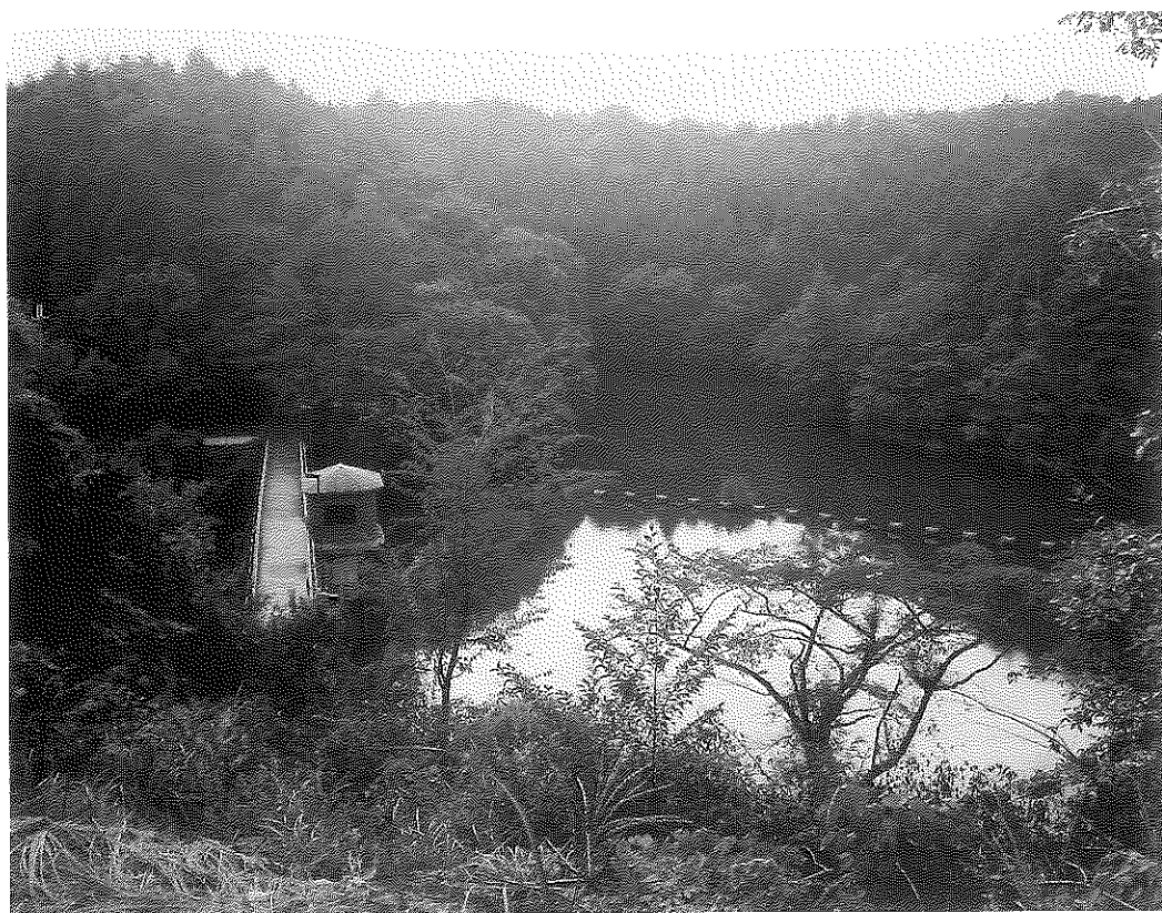
大正池堤体付近（東から）
