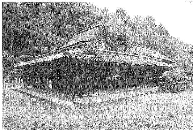
本殿背部（回廊が廻る）
