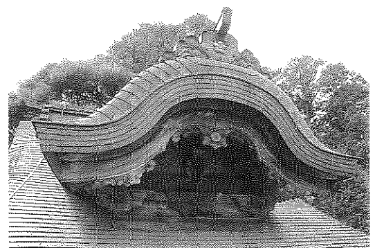
屋根流れから突出する据唐破風
