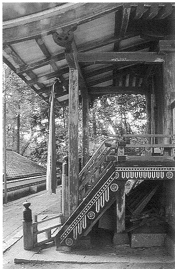
本殿 向拝廻り
