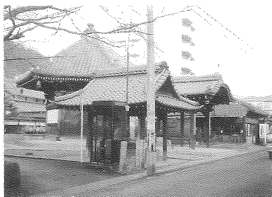
四ノ宮地藏堂（南西から）
