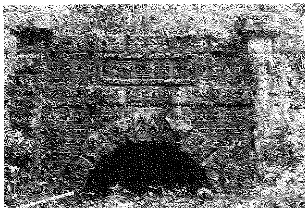
桂貯水池堰堤 水門
