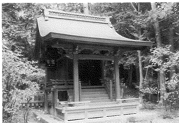
泉涌寺鎮守社本殿
