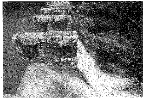
桂貯水池堰堤 溢水道
