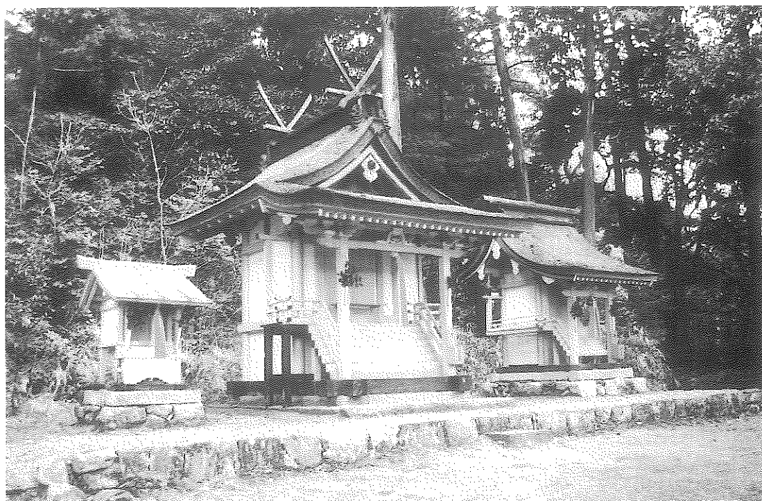
天満宮境内社梅宮神社本殿（中央）・境内社八幡宮本殿（向かって右）
