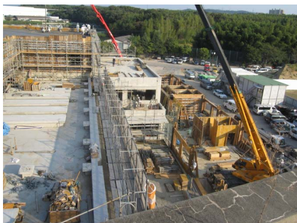
昨年9月の工事の様子（本館・重複棟）
