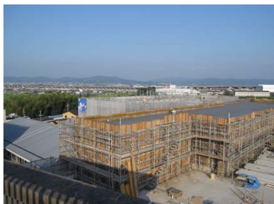
本館・特別棟の工事の様子
