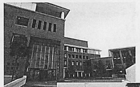
〈京都障害者校・本校(くいな橋)〉
