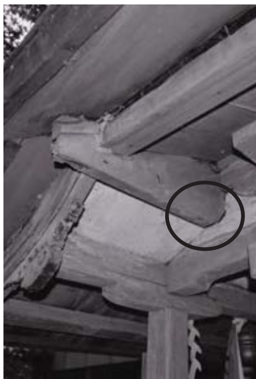
末社八王子社 障泥板詳細 障泥板が取り付く位置の下端は丸く削られ、破風板から障泥板へと発展していく過渡的な形状を示しているものとみられる。
