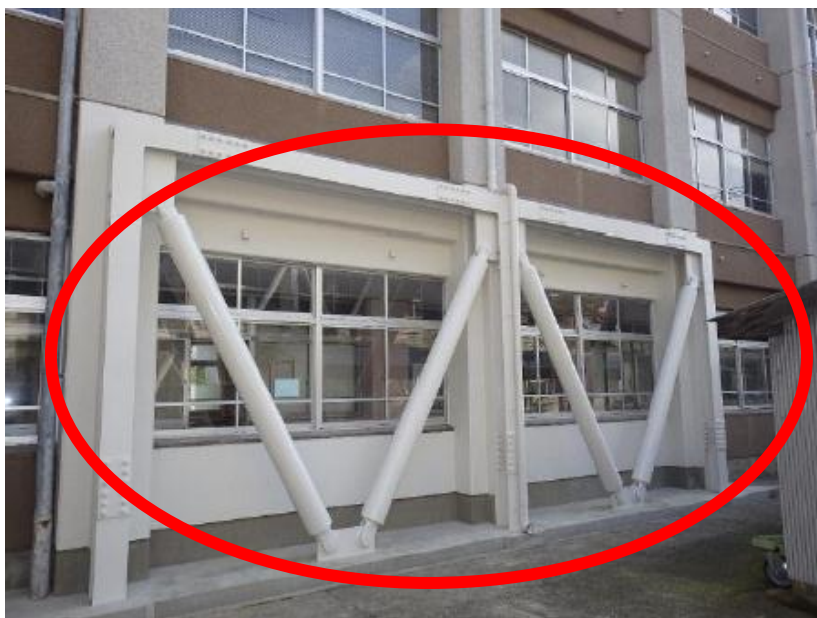
耐震補強工事の様子(府立網野高等学校 特別教室棟・教室棟)
