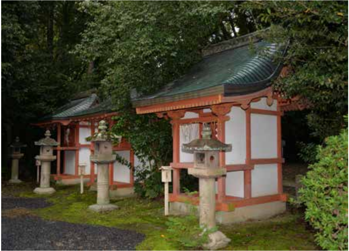
末社春日社本殿（手前）及び末社日吉社本殿（中央）、末社住吉社本殿（奥） 外観
