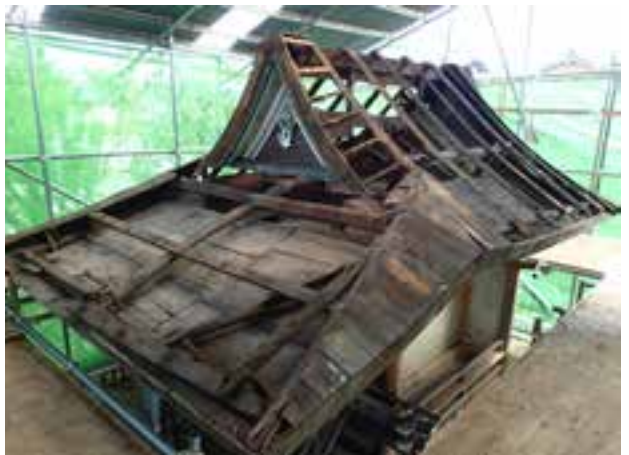
平成 28 年修理中の様子
