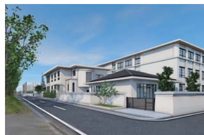
校舎南西(寺町通)より
