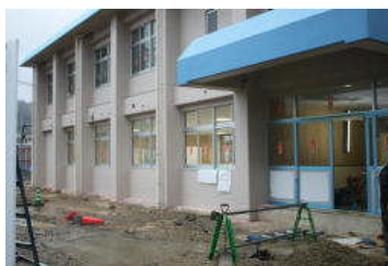
【生徒昇降口から見た新校舎】
