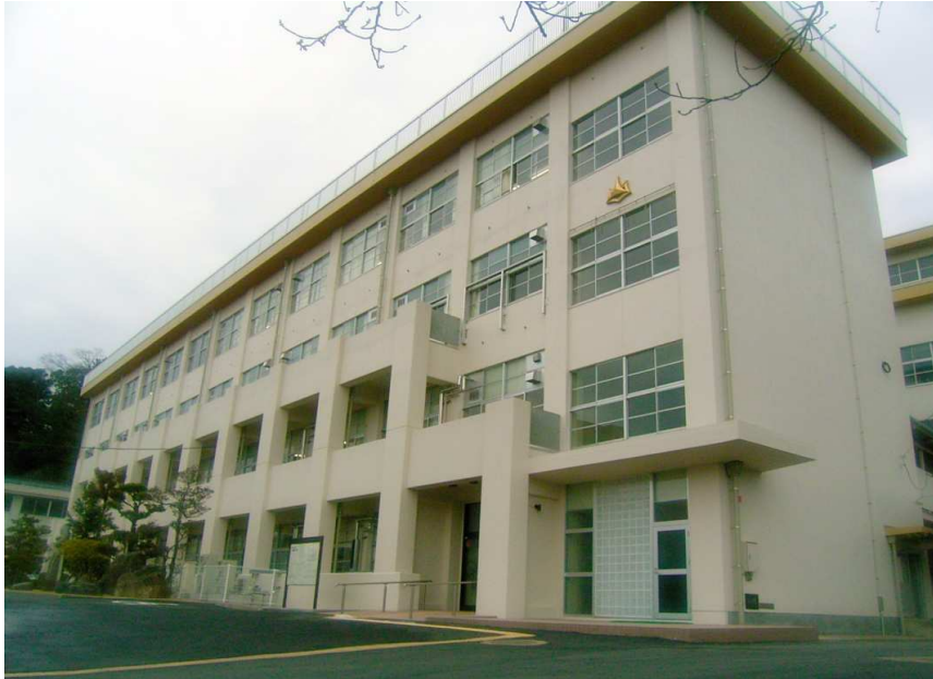
アウトフレーム工法(峰山高等学校)
