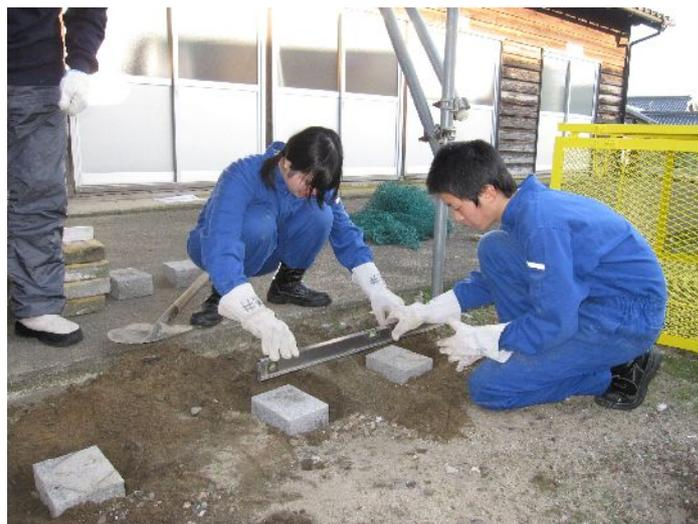
水平器械で設置ブロックを埋設
