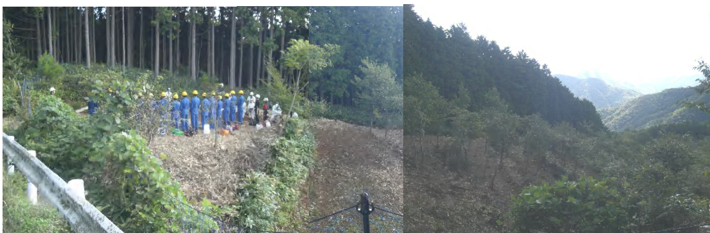
杭打ち現場“大江山シンボルゾーン” 宮津街道入口より撮影
