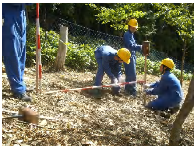
植樹用の杭打ち(2m間隔)
